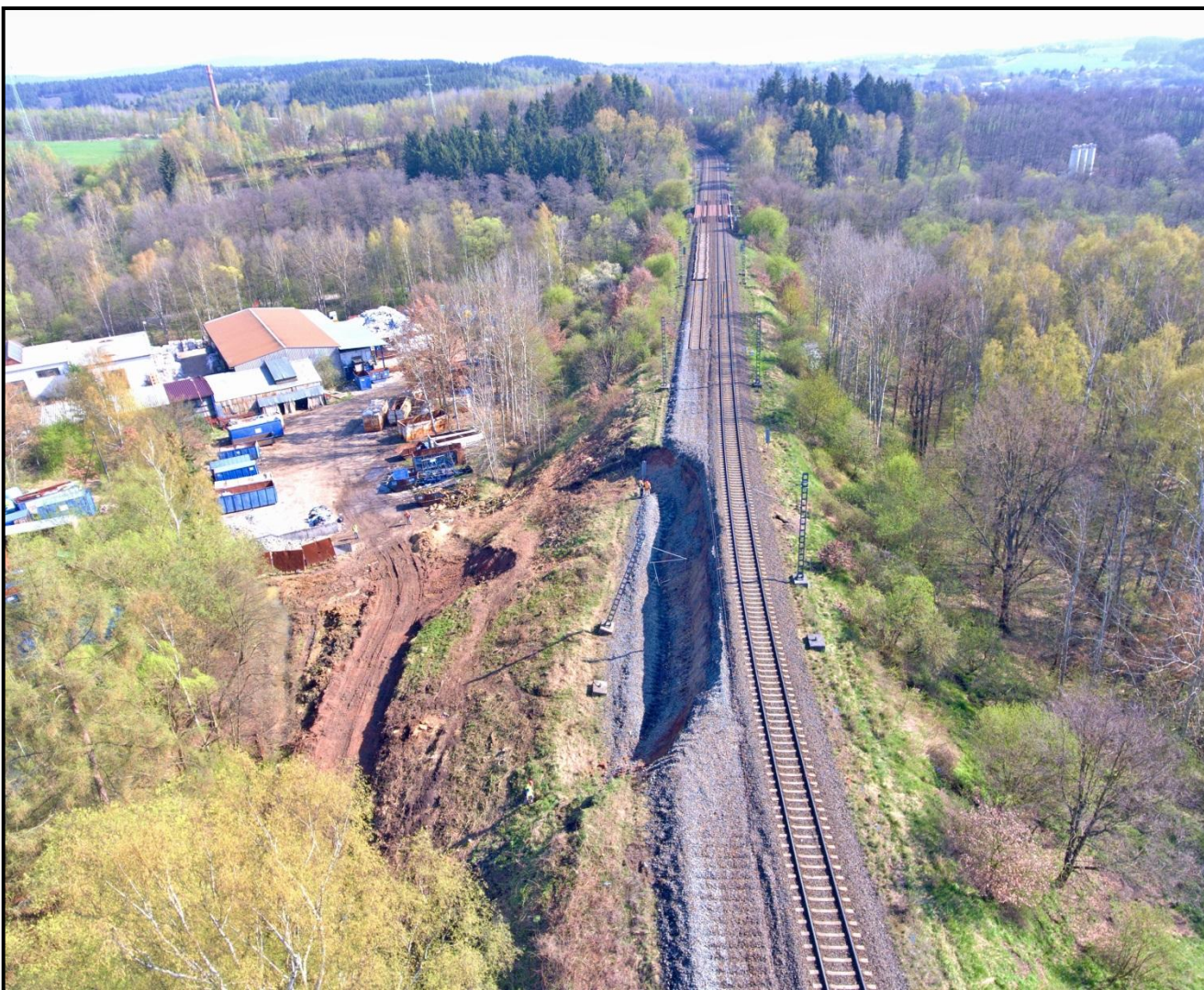
Železniční násep u Dalovic (Karlovarsko) není sesuvem, ale stavebním objektem. Foto M. Dostálík.
