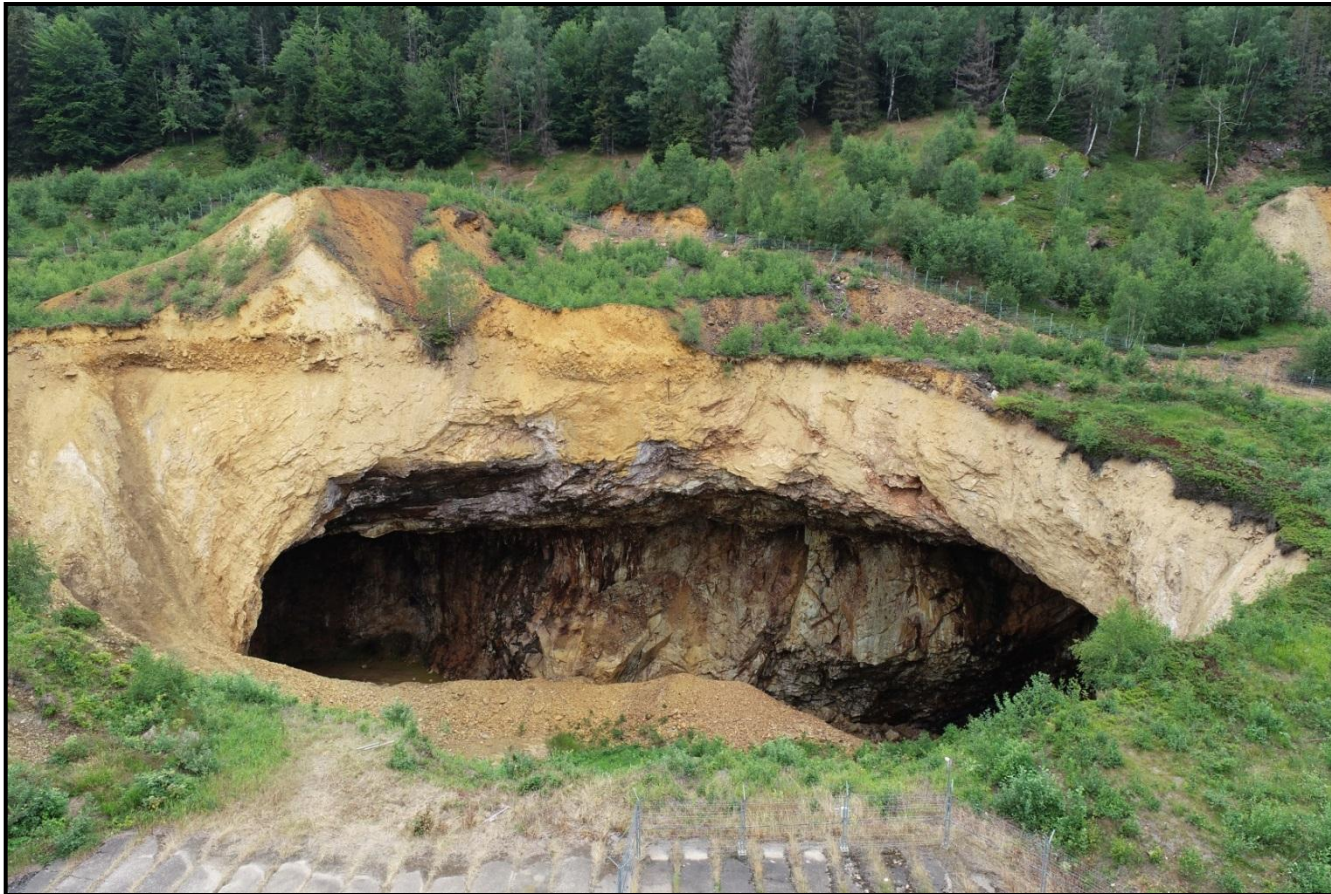
Lokalita Žebračka ve Zlatých Horách. Důlní propad se skalním řícením, monitorovaným seismologicky. Foto J. Nečas.
